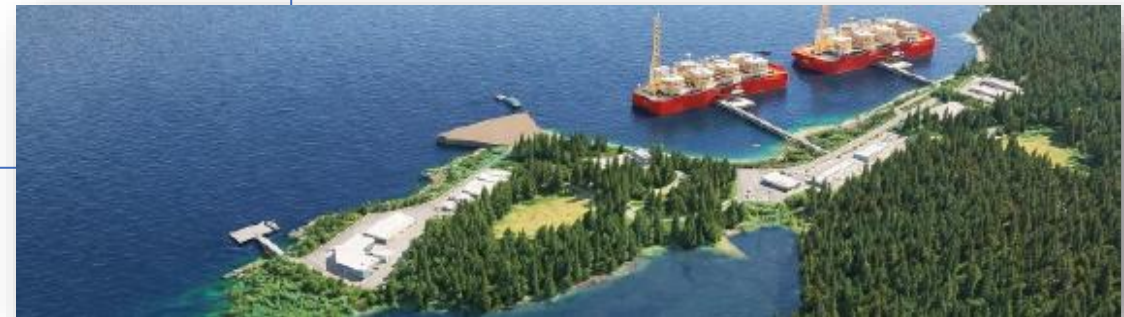
Ksi Lisims LNG Terminal (Government of Canada, 2026)
