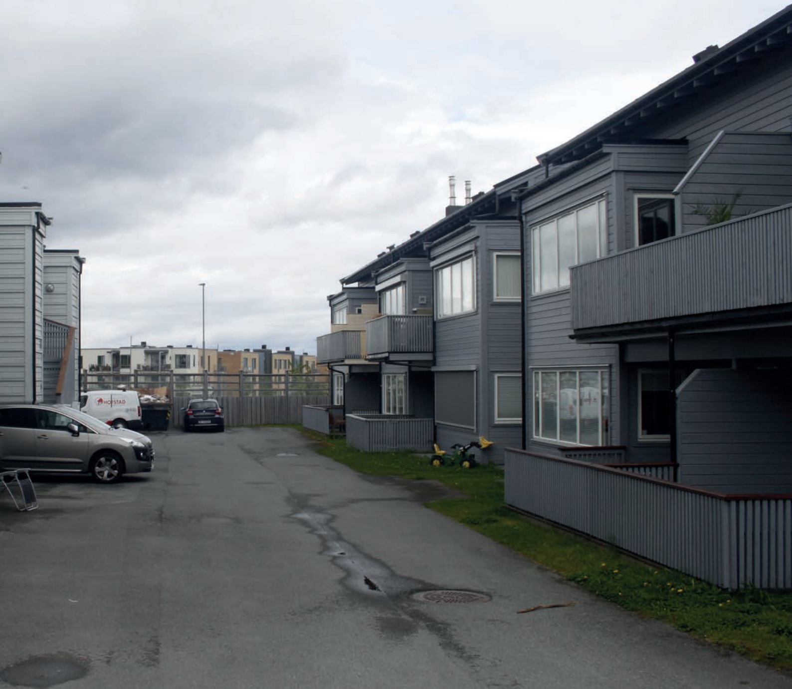
Utsyn mot Grilstad marina mellom typologi A, firemannsboligene
