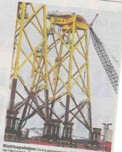
Sluttinspeksjon: De tre personene som befant seg i krankurven Kværner Verdal bygger for det tyske firmaet RWI Innogy. Kurven var heist opp med kran slik at de tre arbeiderne skulle få oversikt over den nesten 50 meter høye konstruksjonen. Foto: LEIF ARNE HOLME
