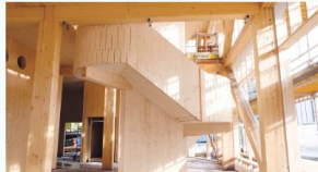
Hovudtrappa i ZEB-laboratoriet er utforma med eit ønske om å bruke minnast med stål.
