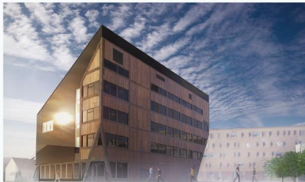
ZEB-laboratoriet til NTNU og SINTEF er under oppføring på Gleshaugen i Trondheim.
