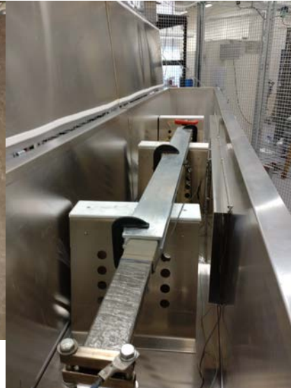
Figur 3 Generatorstaven oppkoblet i varmeskapet.
