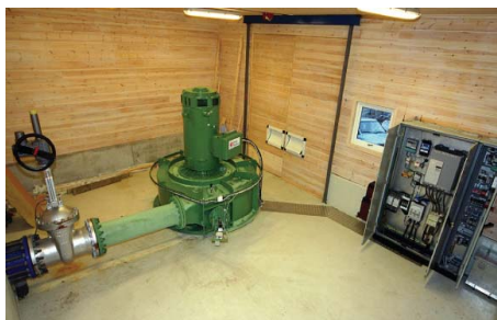
Fig 5.13 Viktigste komponenter i et vannkraftverk: Inntaksrør m/ventil, turbin, elektrotavle for kontroll av maskiner samt leveranse av strøm til nettet.
