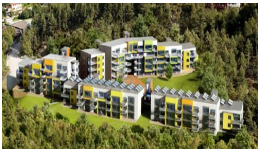
Fig 2.6 Passivhus. Blokkleiligheter. Løvåshagen i Bergen.
