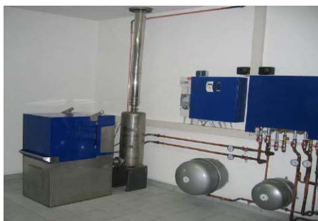
Fig 5.20 Micro CHP. Anlegget benytter biodiesel for å produsere elektrisk energi og varmt vann
