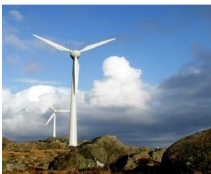
Fig. 5.4 Frittstående vindturbin. Kilde: Utsira Kommune
