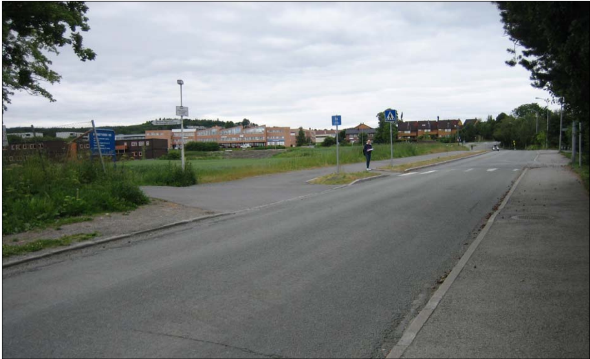
Bilde 7: Gang- og sykkelvei langs Brøsetveien slutter brått. Myke trafikanter må over i veibanen eller krysee veien og benytte seg av et smalt og humpete fortau på motsatt som fortsetter videre nedover Brøsetveien. Dette fortauet er ikke egnet for syklistene på grunn av mange private utkjørsler og kryss som kan skape farlige situasjoner.
