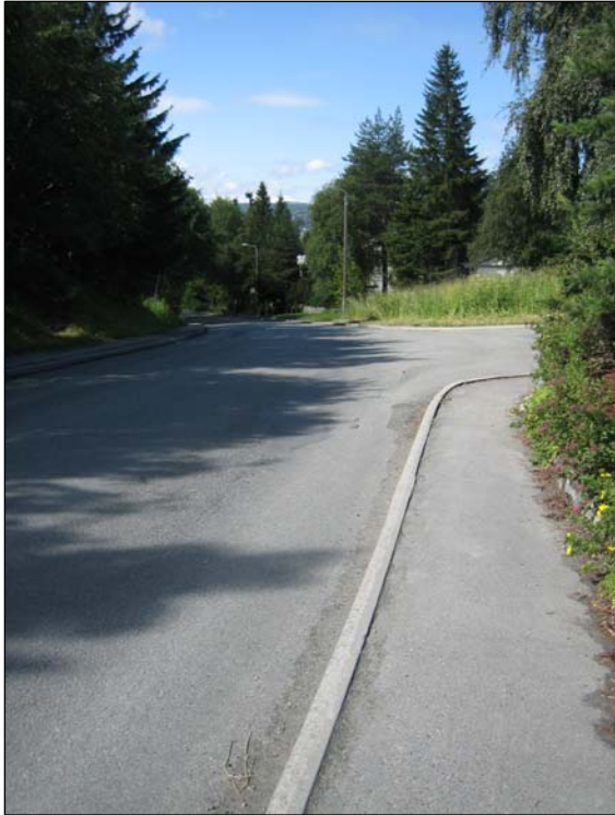
Bilde 12: Dybdahlsvei er en del av Tyholtruta, men mangler en helhetlig sykkeltrase. Et smalt fortau i øvre del av bakken ender brått og tvinger syklister ut i veibanen.
