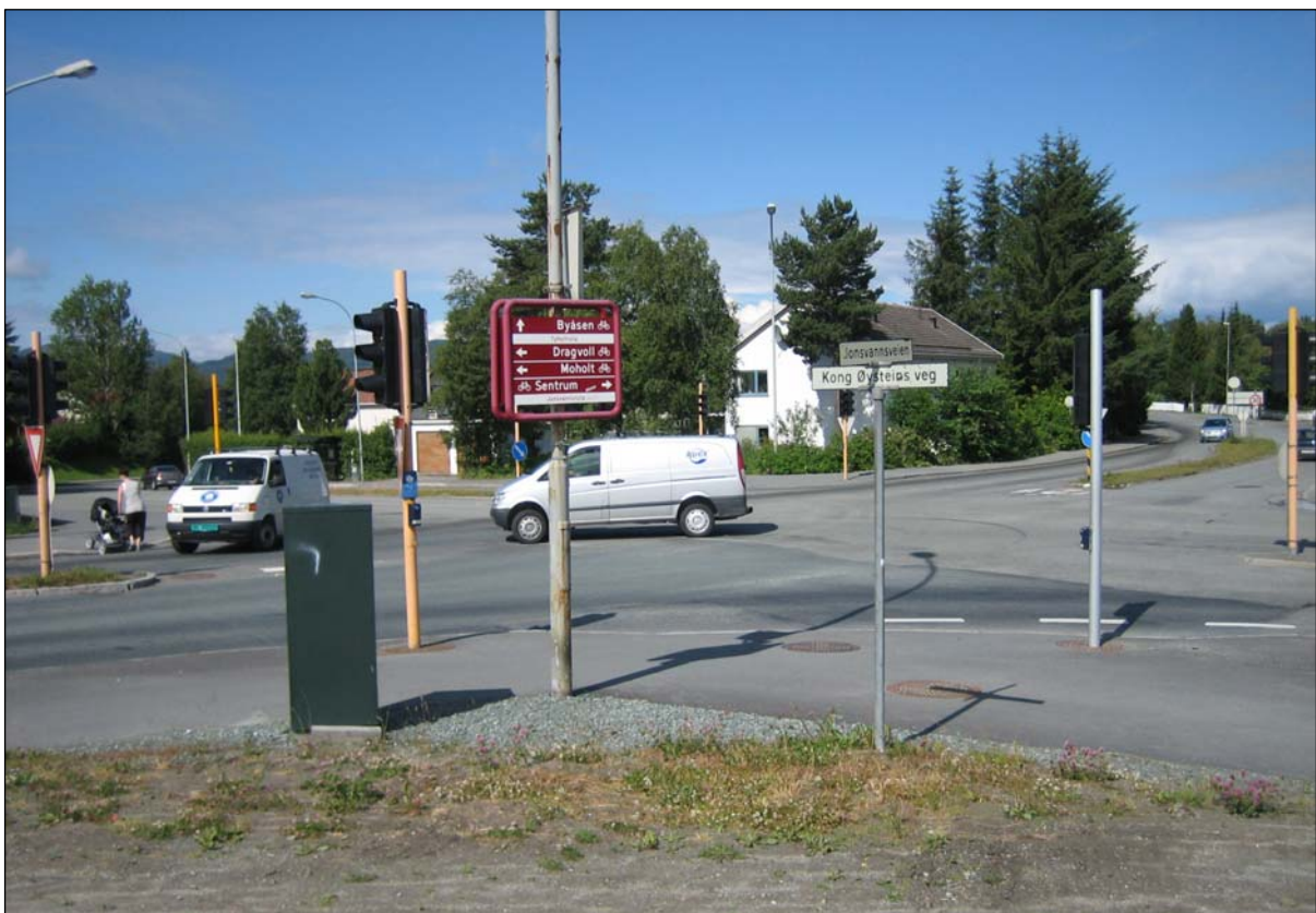
Bilde 11: Lyskrysset mellom Jonsvannsveien og Dybdalsveien er uoversiktlig og vanskelig å forsere for syklister i veibanen. Krysset er ett krysningspunkt mellom to viktige sykkelruter (Jonsvansruta og Tyholtruta)
