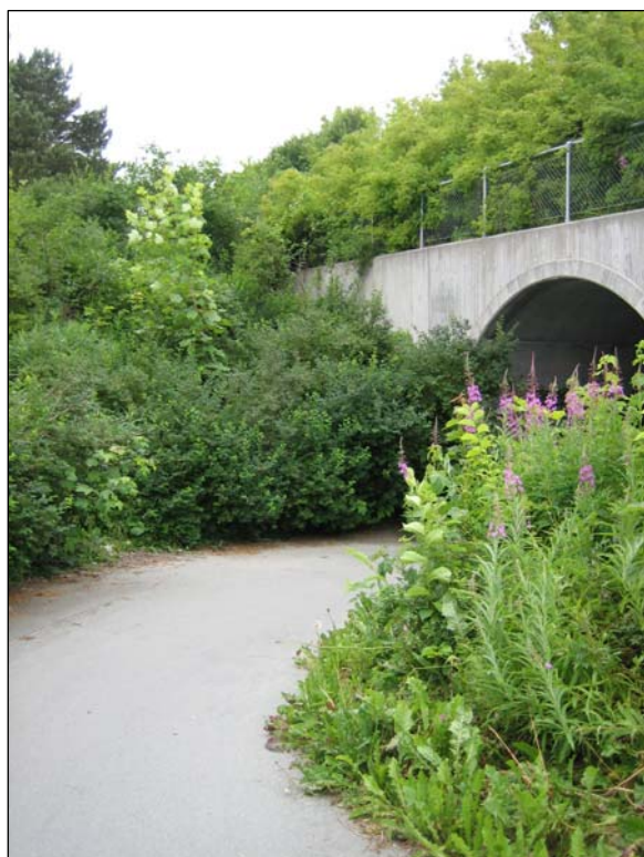
Bilde 5: Undergang ved Angeltrøveien, fritt voksende vegetasjon gir dårlig sikt. Undergangen føles utrygg fordi den er så skjermet fra omgivelsene.
