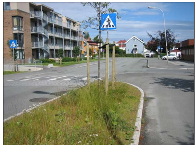
Bilde 9: Krysset er utydelig med mulighet for syklistene både i veibanen og på fortauet. I tillegg er det biltrafikk fra tre veier samt utkjøring fra parkeringskjeller hvor bilene tvinges til å stoppe på fortauet før de kjører ut i veibanen.
