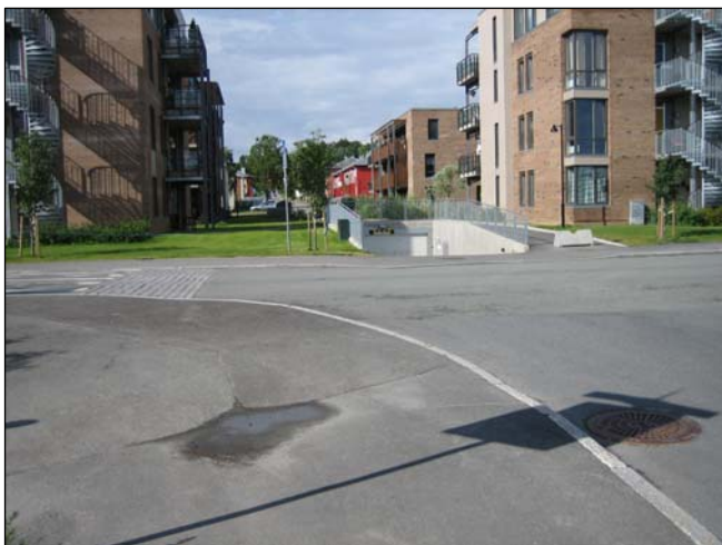
Bilde 8: Kryss i Fernanda Nissens vei med utkjøring fra parkeringskjeller midt i krysset. Dette bidrar til å skape usikkerhet blant trafikanter.
